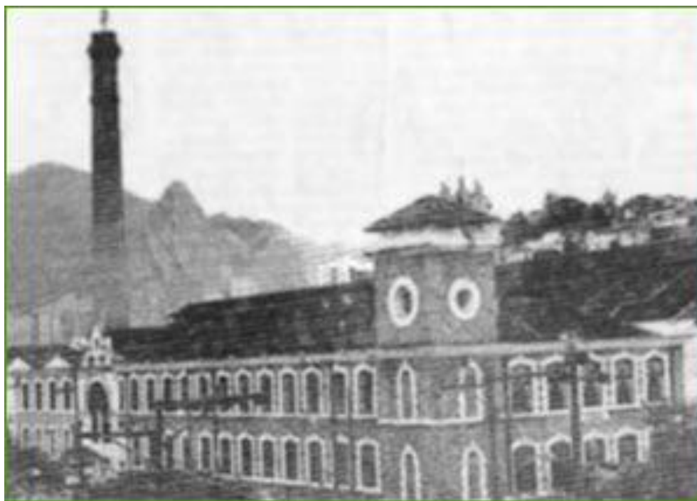
Figura 1: Fábrica Confiança, localizada no bairro de Vila Isabel. Fonte: https://aviladenoelumbairromusical.wordpress.com/category/2-historia-de-vila-isabel/2-6-a-fabrica-de-tecidos-confianca/
