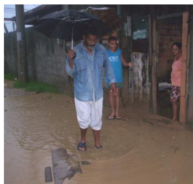
Deficiência do sistema de drenagem. Fonte: NEPHU
