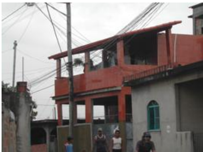
Edificação de Uso residencial (2 pavimentos), Rua Saturno. Fonte: NEPHU
