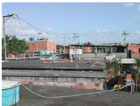
Coberturas das casas em laje de concreto. Fonte: NEPHU
