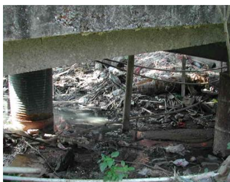
Detalhe da tubulação sob ponte da Rua Mercúrio. Fonte: NEPHU
