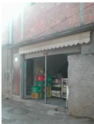
Edificação com Uso misto, comércio e residência, Travessa Estrela. Fonte: NEPHU
