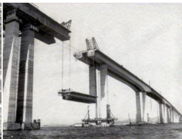
Figura 20: Foto da construção da Ponte Rio-Niterói. Fonte: http://www.skyscrapercity.com . Acesso em 23.07.2014.
