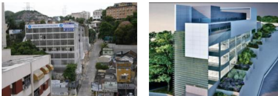
Figura 69: Hospital Santa Mônica e projeto de Diagnóstico por Imagem. Fonte: O Globo, 2012. Disponível em http://www.radiologiarj.com.br/governo-do-estado-inicia-obras-do-rio-imagem-2/ Acesso: 20.09.2015.
