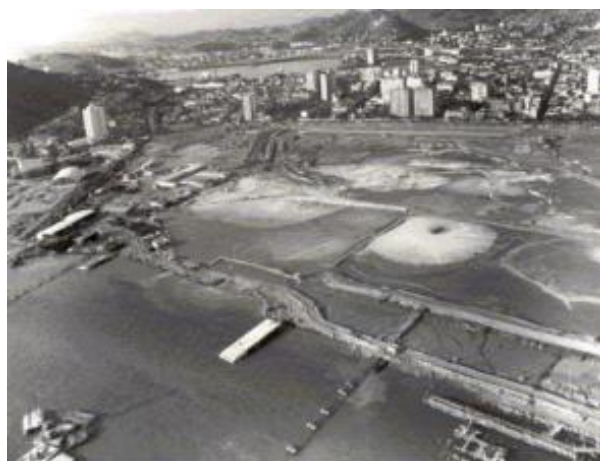
Figura 19: Vista aérea da construção do Aterrado Norte 1973. Foto: Sonia Mendes
