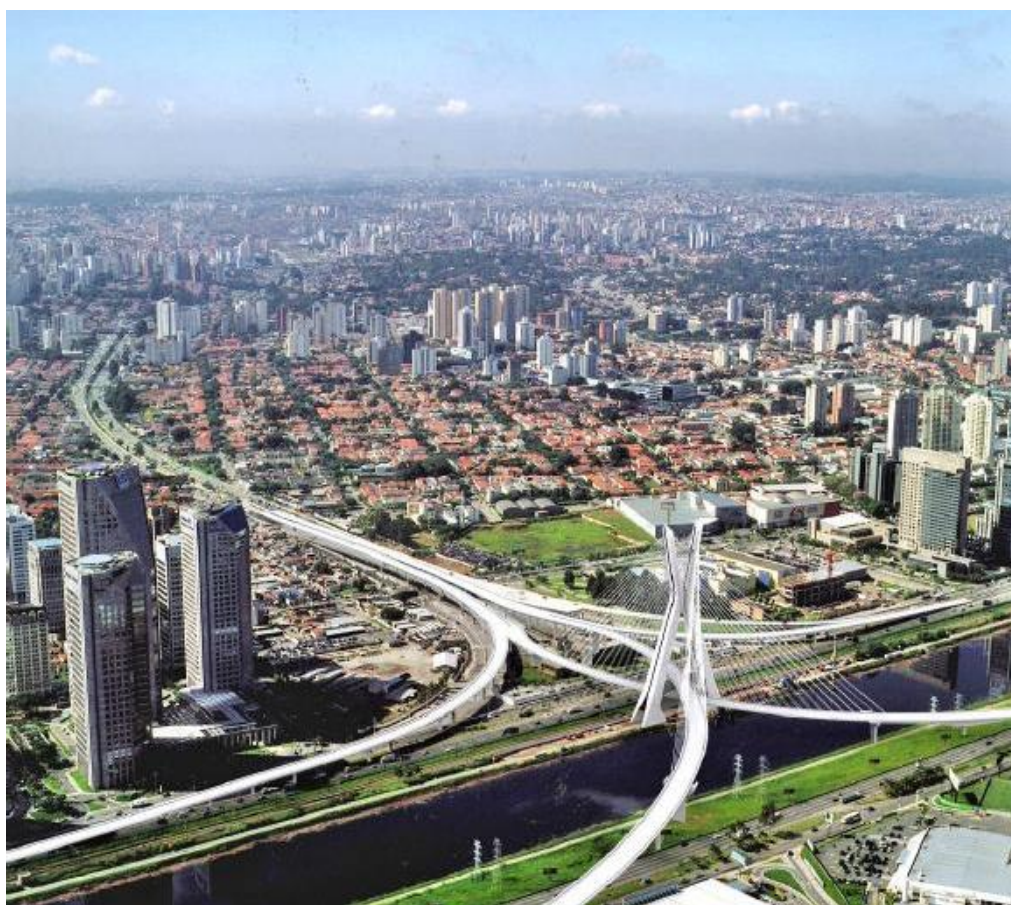
Figura 7: Ponte estaiada sobre o rio Pinheiros Fonte: https://elt0n.files.wordpress.com/2007/02/image004.jpg . Acesso 22.01.2016.
