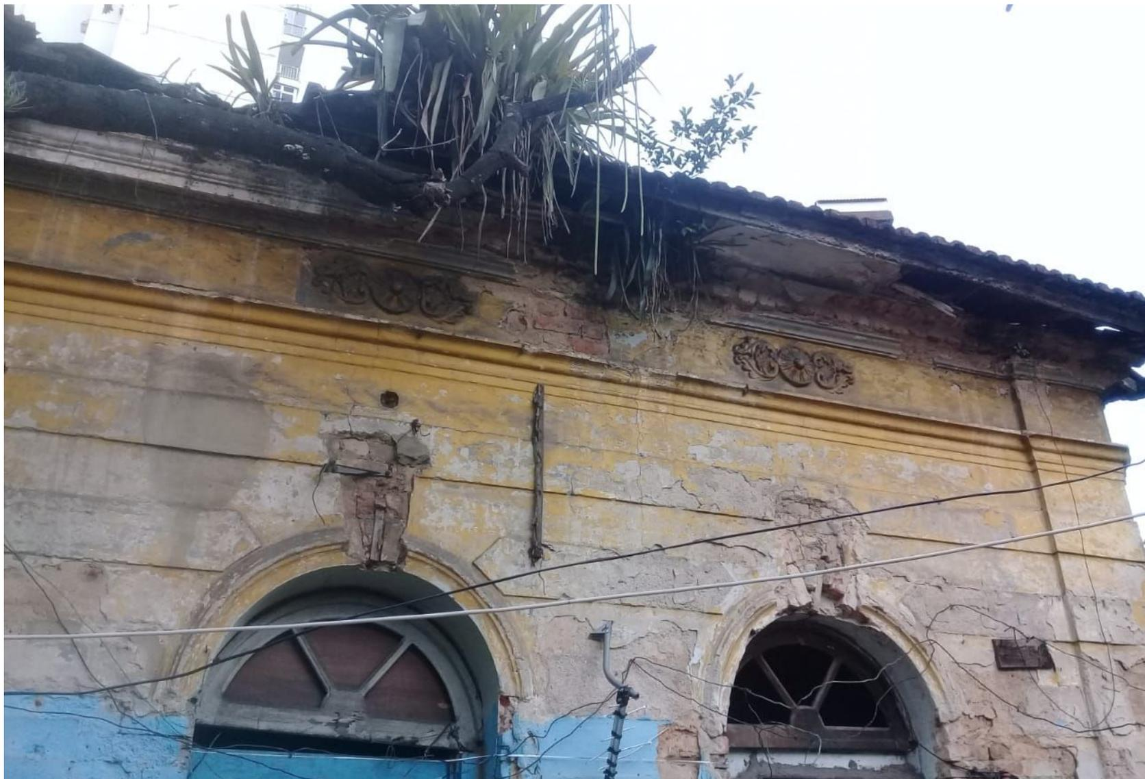
**Fachada com risco de queda de reboco**
