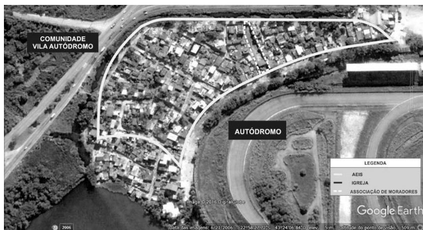
Figura 2. Detalhe comunidade Vila Autódromo
